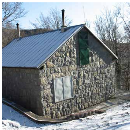
Primjeri neusklađene dogradnje i gradnje, te neprimjerene obrade zida
