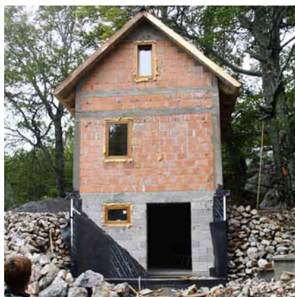
Primjeri neusklađene dogradnje i gradnje, te neprimjerene obrade zida
